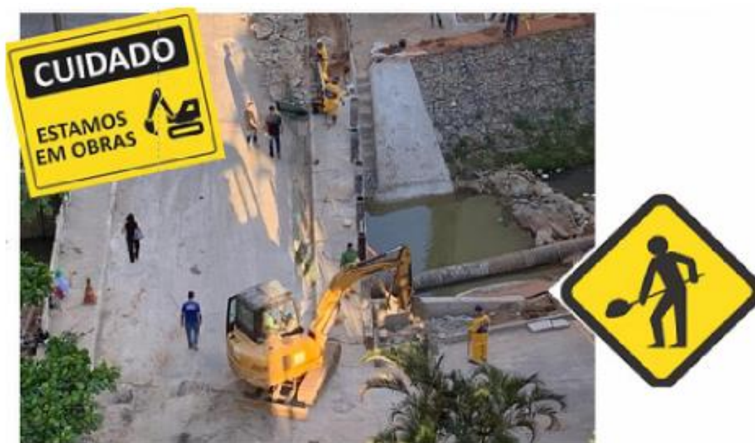
figura 8 - obras de recuperação da porção no condomínio village.
