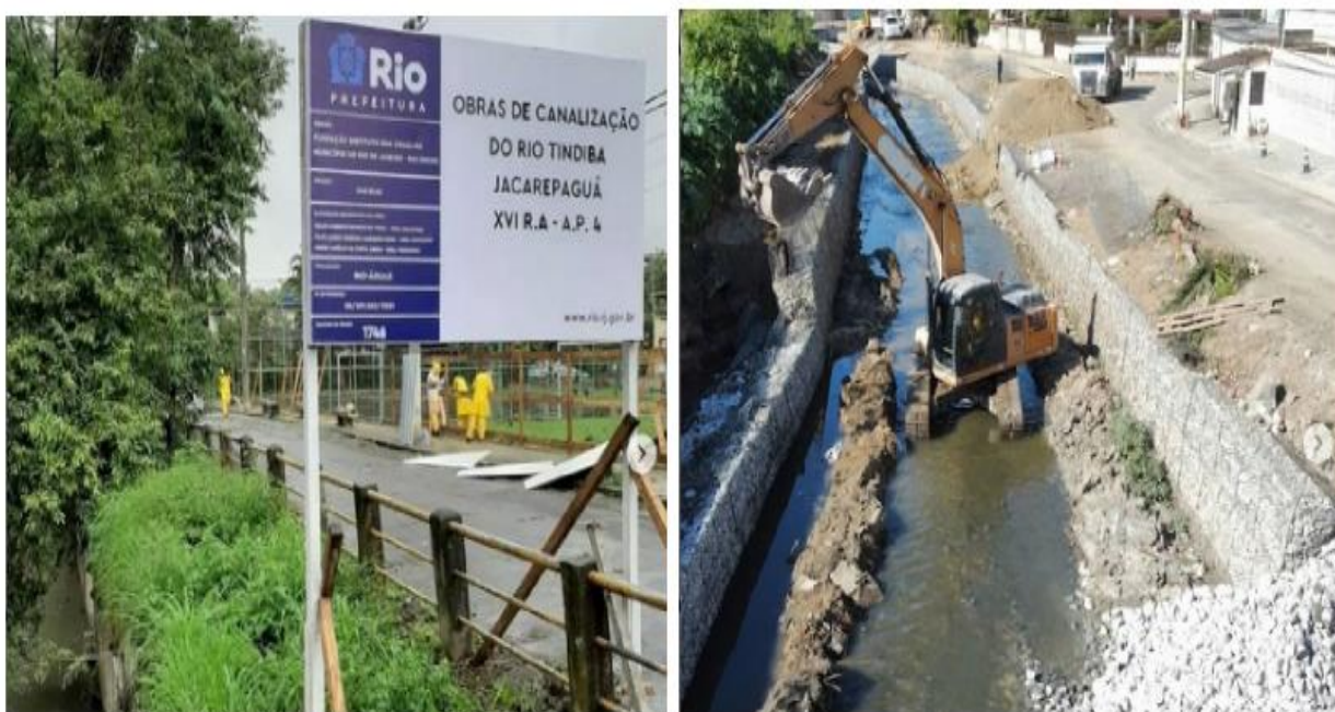
Figura 7 - Obras de Canalização do rio Tindiba
