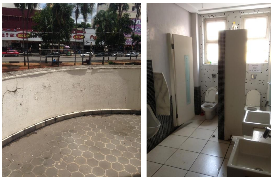
Figura 10- Situação atual do 1º pavimento, sacada e banheiro
